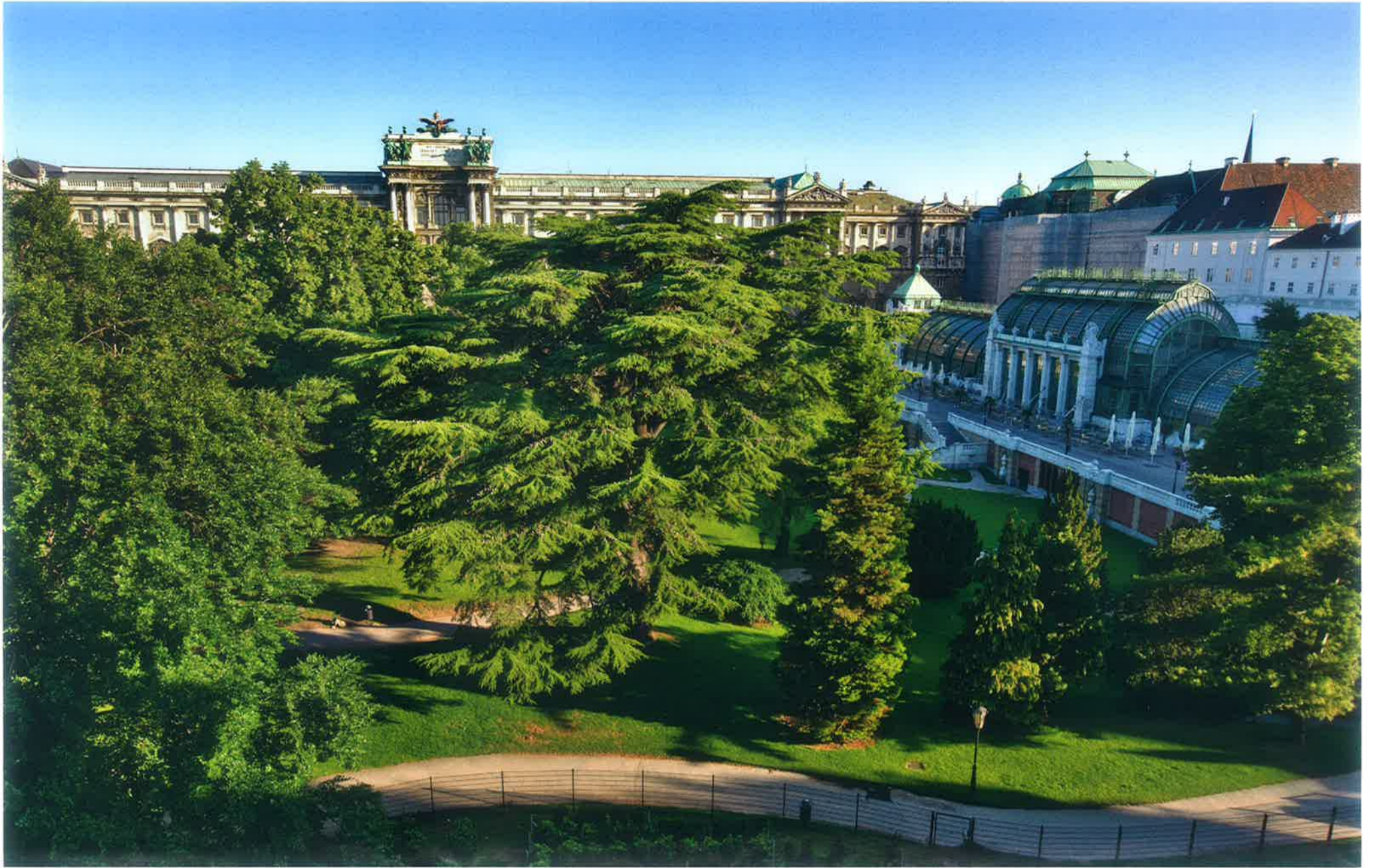
Das Palmenhaus im Burggarten wurde 1822 errichtet und gehört zu den schönsten Stahl- und Glaskonstruktionen seiner Zeit.
